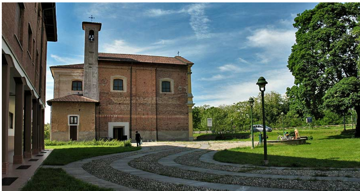
Nerviano, l'Abbazia della Colorina, che si nota sull'asse del Sempione da Milano andando verso Legnano, è dedicata all'Immacolata Concezione.
