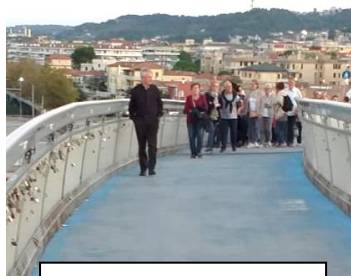
Ponte pedonale Pescara
