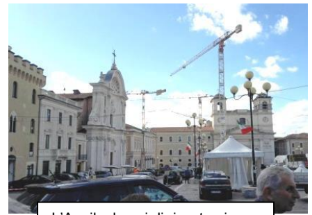
L'Aquila: lavori di ricostruzione
